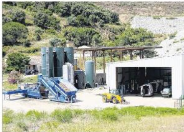
Le site de Saint-Antoine, dépollué à grands frais, a été réaménagé. Les deux presses à balles sont opérationnelles.
