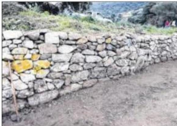
Après le démontage, le tri des pierres et l'assemblage, le mur retrouve son aspect d'origine et sa place dans le paysage.
