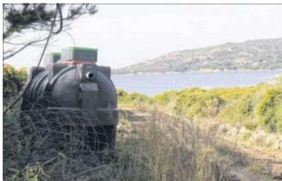
La microstation d'épuration, une solution pour l'assainissement non collectif avec une protection non négligeable de l'environnement. / PHOTO J.D
