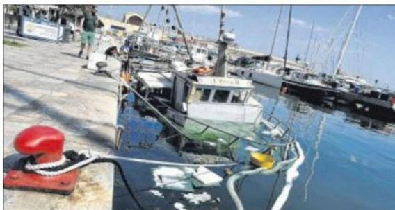
Les équipes du lamanage de Bastia ont effectué la pose d'un deuxième barrage afin de limiter la pollution d'hydrocarbures dans le vieux port de Bastia. Lors de cette opération qui précède le pompage du gasoil et l'enlèvement du chalutier, la circulation sur la zone a été coupée. Une équipe doit ensuite évaluer les dégâts de cette pollution dans les eaux du port.
