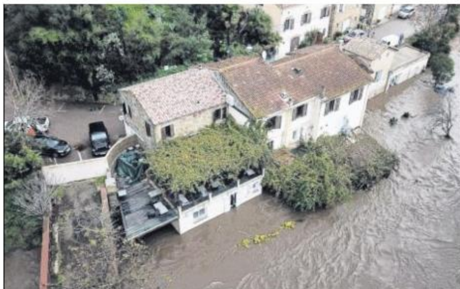
L'auberge du Prunelli a été dévastée dans sa partie basse par la crue du fleuve. La montée subite des eaux a bien failli prendre ses occupants par surprise.
