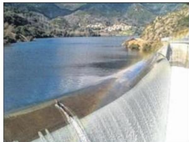
Durant la crue, les déversoirs ont permis d'évacuer le trop-plein du barrage.
