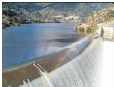
Durant la crue, les déversoirs ont permis d'évacuer le trop-plein du barrage.
