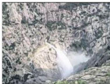
À NOTER : LEAUX TERRE DE 20 ET 50
