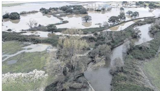
Entre 400 et 500 000 m 3 d'eau se sont déversés sur la piste de l'aéroport lors de la crue centennale de la Garonne, fin décembre, le tronçon CCM de la digue - qui s'étend sur 2 300 mètres jusqu'à l'embouchure - n'ayant pas rompu mais ayant subi une surverse.
