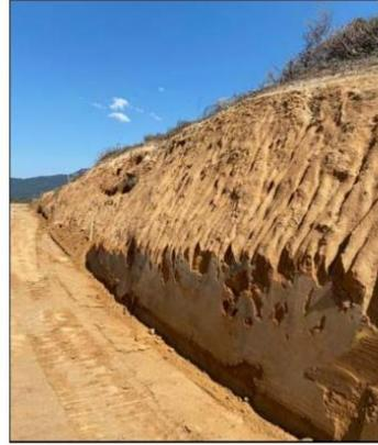
**L'élargissement de la chaussée a nécessité de creuser dans la roche.**
