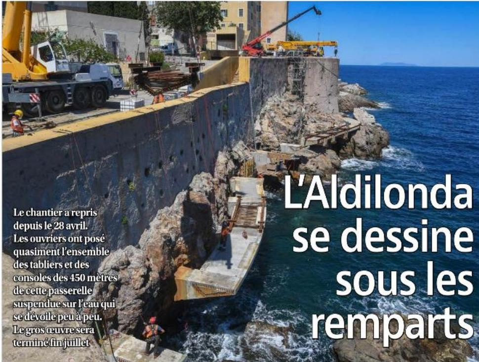
**Le chantier a repris depuis le 28 avril. Les ouvriers ont posé quasiment l'ensemble des tabliers et des consoles des 450 mètres de cette passerelle suspendue sur l'eau qui se dévoile peu à peu. Le gros œuvre sera terminé fin juillet**
