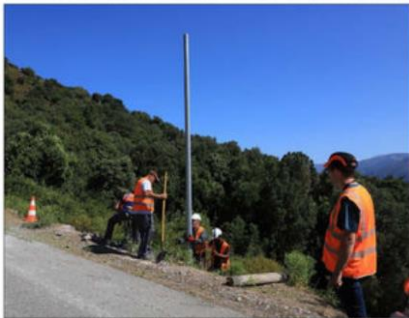
Les nouveaux poteaux sont en métal, plus facile d'entretien et plus difficile à dérober.
