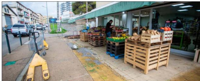
Certains commerces ont pris des dispositions de sécurité pour prévenir d'autres épisodes pluvieux. Mais leurs gérants réclament des travaux d'urgence.
