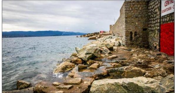
Des modélisations réalisées dès 2014 ont permis d'identifier les fragilités de l'ouvrage vis-à-vis des vagues portées depuis le golfe par les vents de Sud-Ouest.
