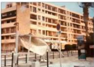
Un abris fortement endommagé par le vent dans le quartier de Toga à Bastia.
