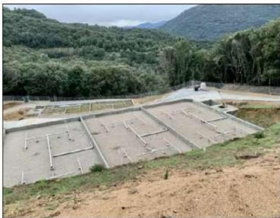
Station d'épuration d'Olivese, en décembre 2020. En construction, elle sera mise en service dans le courant de l'année 2021 et fonctionnera aussi sur le système de roseaux.
