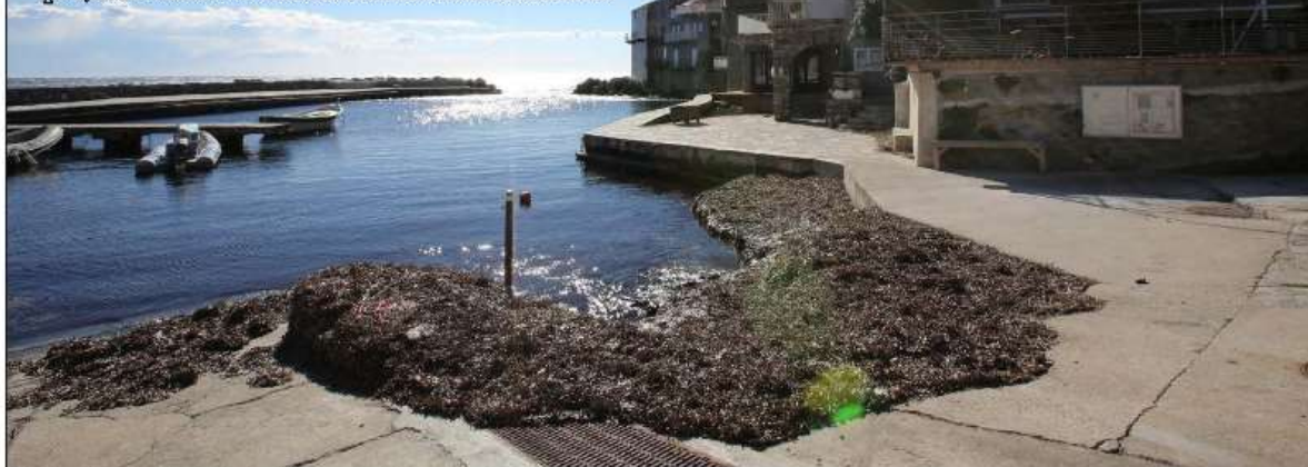
À Erbalunga, le port est dans l'attente de travaux depuis le 29 octobre 2018...
