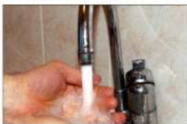
« Tous les systèmes existants à ce jour dans l'habitat utilisent des pompes électriques car les réseaux de distribution d'eau potable et d'eau de pluie doivent être séparés. »
