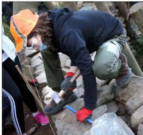
L'art de la pierre sèche au cœur du chantier Form Bridge.
