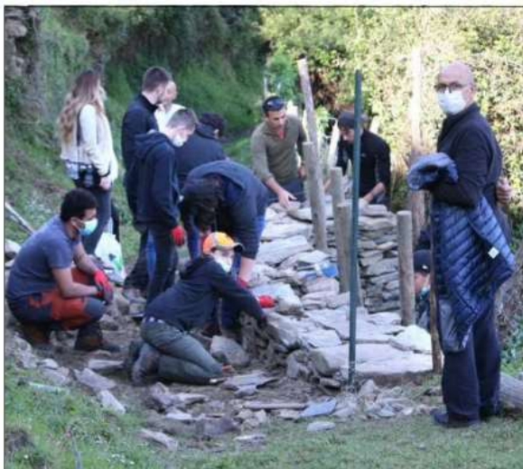
Chantier Erasmus sur le sentier du patrimoine.
