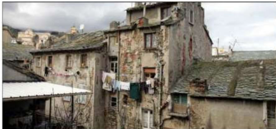
Les logements anciens sont particulièrement énergivores, et ceux classés G seront interdits à la location dès 2025. ARCHIVES CM
