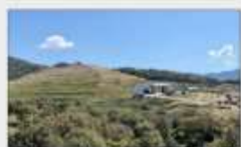
En 10 ans, quelque 700 000 tonnes de déchets ont été enfouies à Viggianello I.
