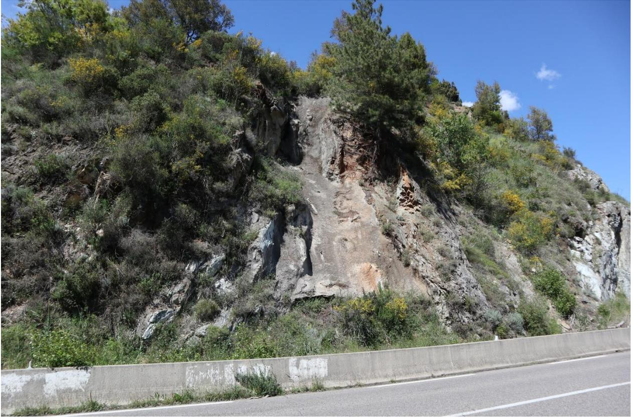
*Figure 250 : Illustration de l'utilisation de béton projeté sur un affleurement de serpentinites. Route territoriale T20.*
