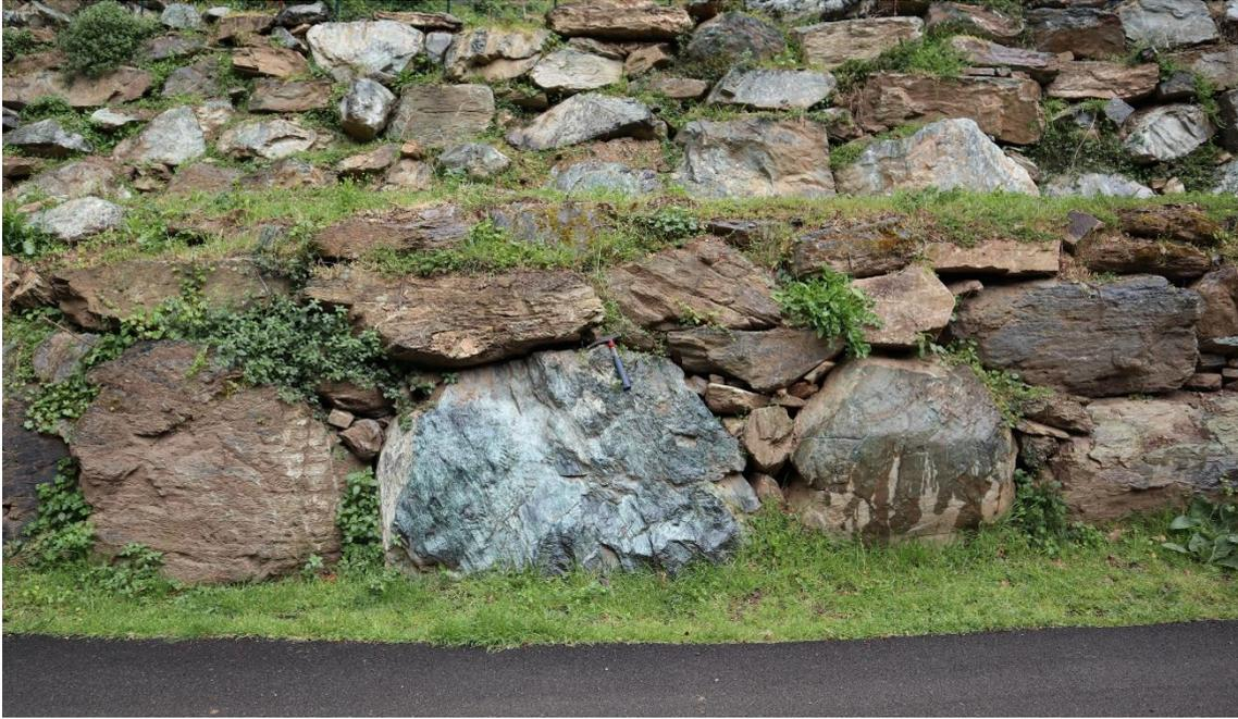
Figure 251 : Illustration de blocs de serpentinites à plan fibreux utilisés en mur de soutènement.
