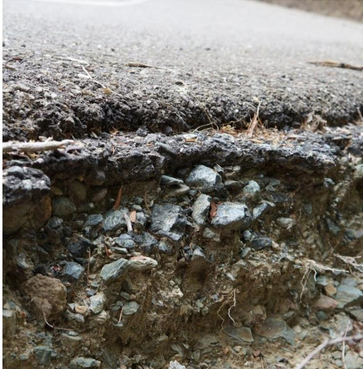
*Figure 252 : Photo d'un profil de la route D105. La couche de forme est un remblai composé de serpentinites.*
