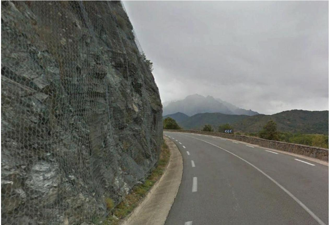
*Figure 62 : Affleurement de serpentinites formant un talus de la route T20, Valle-di-Rostino. La route est protégée des chutes de blocs par un grillage plaqué. Ces installations réduisent également le risque de dispersion de fibres.*
