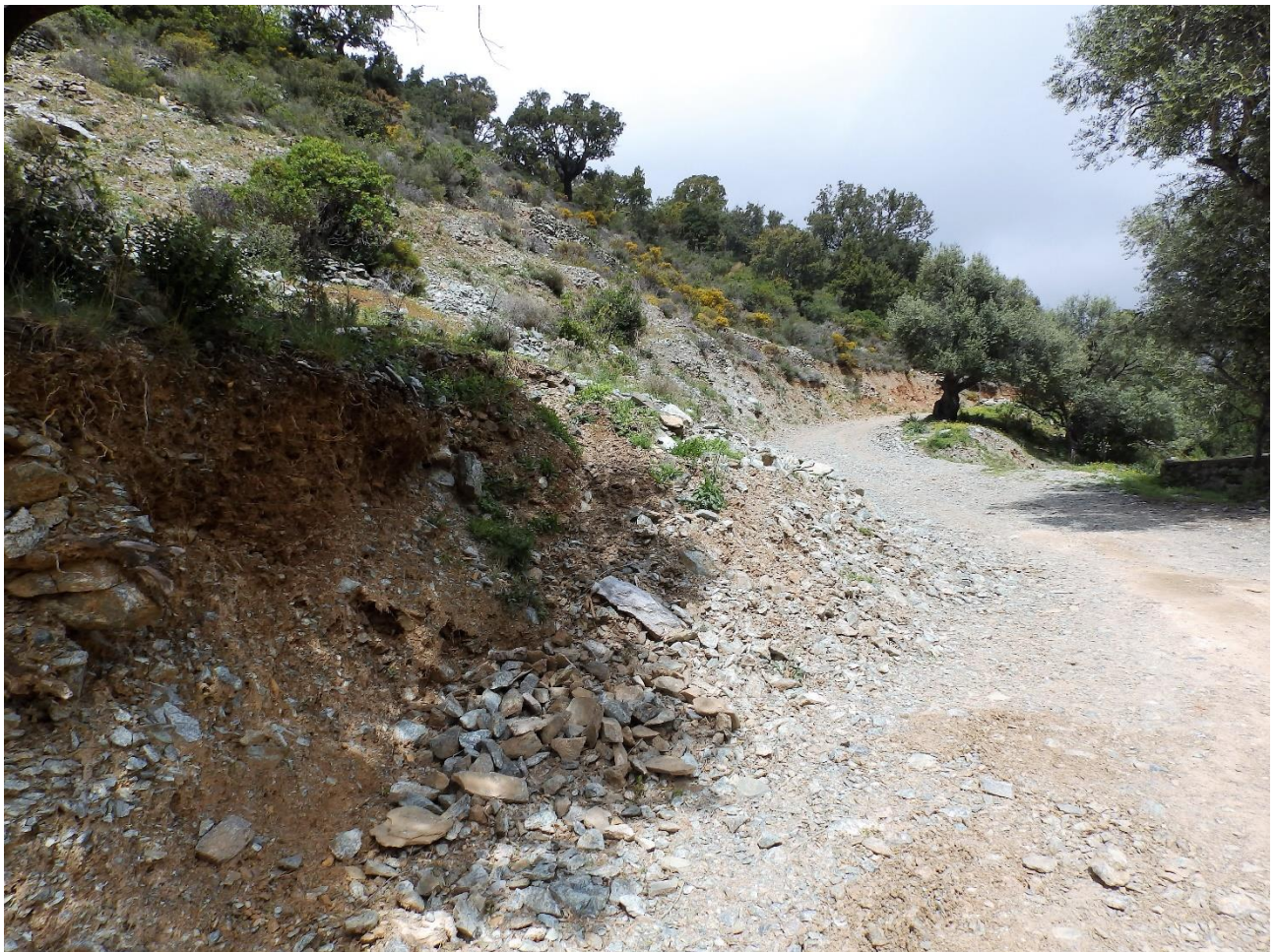
Figure 168 : Piste ouverte dans des serpentinites très fracturées et riches en amiante (Commune d'Ometa-di-Capocorso).
