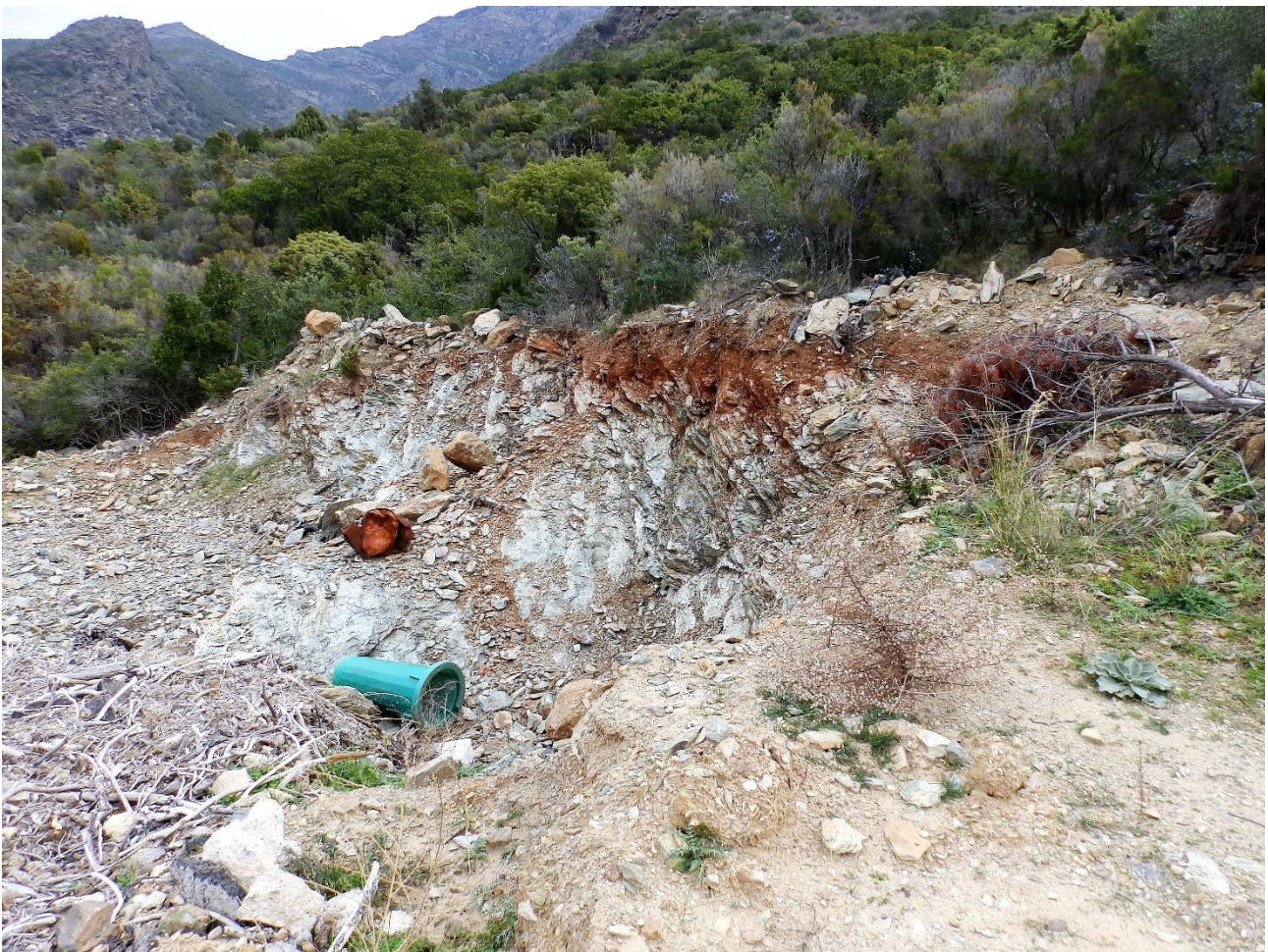
Figure 169 : Petite carrière ouverte dans des serpentinites amiantifères, partiellement remblayée mais encore utilisée pour des dépôts sauvages (commune de Farinole).
