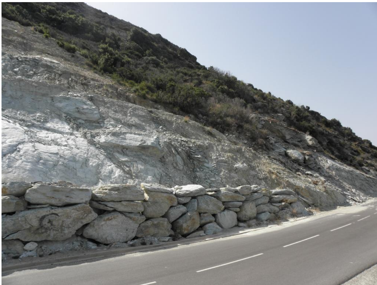
Figure 171 : Confortement de talus par la pose de blocs en limite de voirie (D80, secteur de Canelle).
