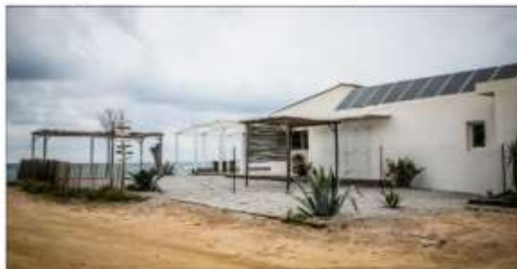
Little Capo, sur la plage de Valitella sera ouverte cet été. Les scellés avaient pourtant été placés il y a plusieurs semaines, en vue de la démolition des lieux.
