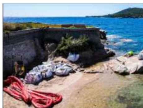
Après la démolition, une petite plage est réapparue.
