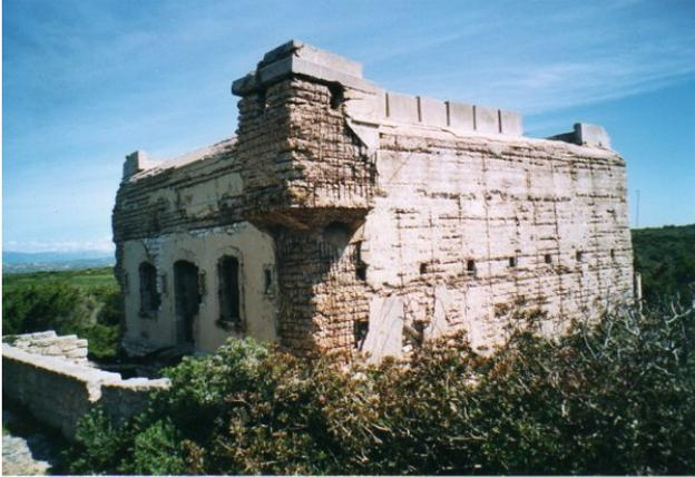
aujourd'hui à moitié ruiné, aux allures de château avec ses deux échauguettes, est bâti en 1901. C'est en réalité un réduit de batterie qui doit protéger la batterie de Bocca di Valle de toute attaque venant de l'arrière. Lui-même est protégé par un fossé, une grille et un réseau de barbelés. Il est armé de 2 canons de 37 mm à tir rapide. Il ne disposait que d'une porte et de deux fenêtres, sur son arrière (du côté des batteries).
