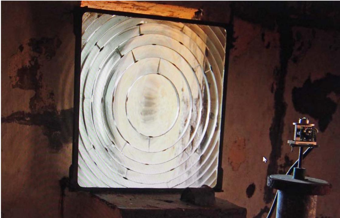
*Pan de l'optique originelle de Pertusatu, installée à Fenu, avant son démontage en 2015*
