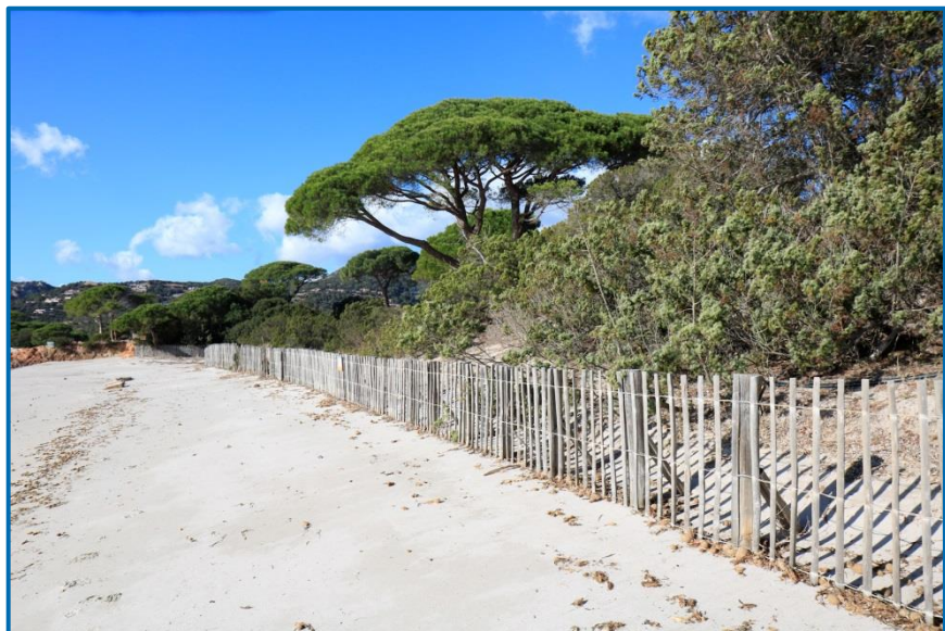
Un grand linéaire de ganivelles a été remplacé sur le site de Palumbaggia.
