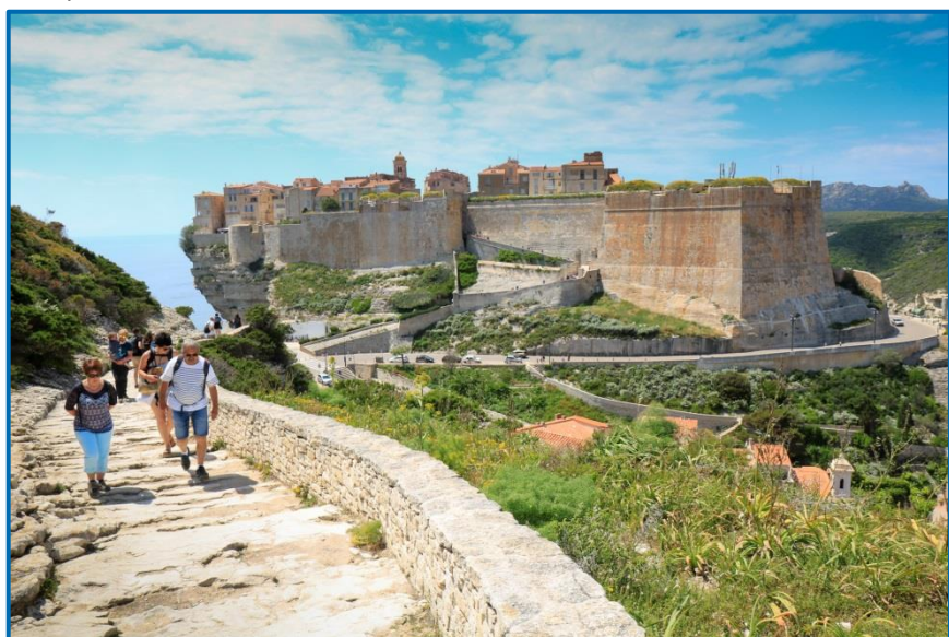
La fréquentation du site de Campu Rumanilu a dépassé le seuil des 200 000 visiteurs pour la première fois en 2017.
