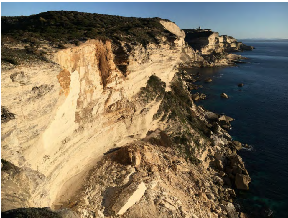
Photo 3 Eboulement récent de la falaise de Bunifaziu
