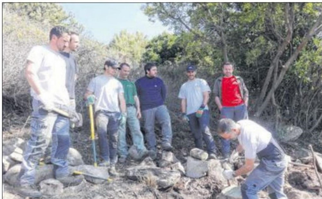
Les agents de protection de l'environnement qui travaillent sur le chantier ont été formés pour réaliser la réhabilitation des murets. /PHOTOS J.-F. P.
