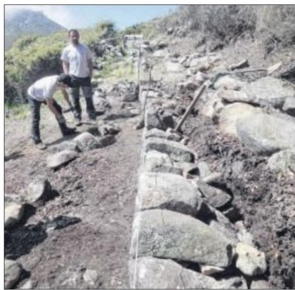
Pierre après pierre, le chemin que les anciens fontainiers fréquentaient quotidiennement reprend forme.
