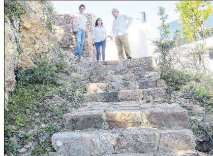
Escaliers, murs en pierres sèches, des techniques et matériaux traditionnels pour donner une authenticité à la promenade.
