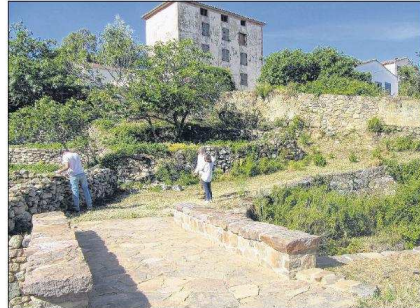
Des travaux de réhabilitation du patrimoine existant sont réalisés à Galeria. /PHOTOS J.C.
