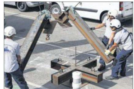
Le deuxième récif artificiel, en forme de croix, nécessite un assemblage en fer. Il sert à attirer les poissons plats.
