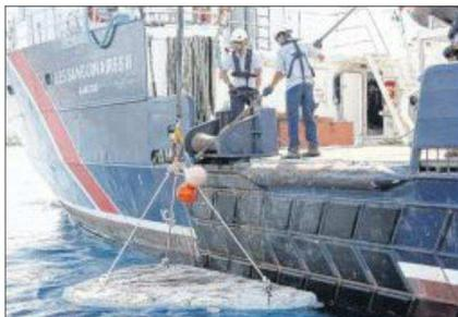
L'équipe des phares et balises 2A s'occupe de placer et d'immerger les blocs de béton qui constituent le récif artificiel.
