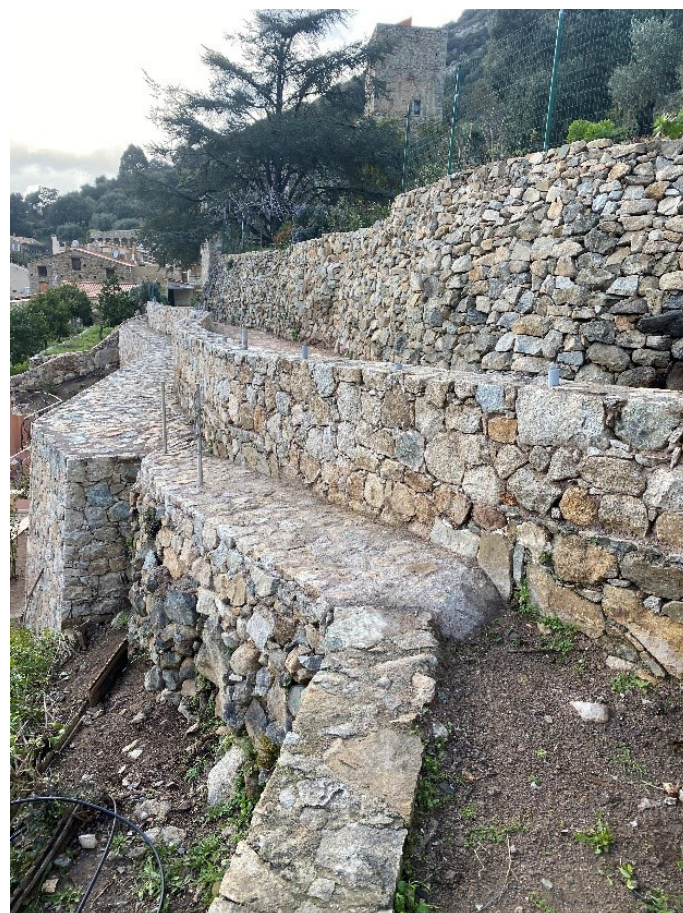
Les travaux de restauration du sentier du patrimoine d'Occi à Lumiu ont débuté en 2022.
