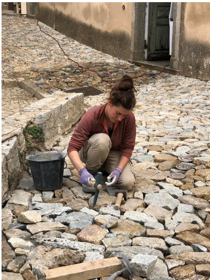
Restauration d'une chjappata sur la commune d'I Spiluncatu
